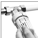
6 Photo 6: Repositionner la poignée manuelle pour que le chiffre «3» soit en face du trait de repère.
